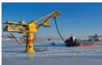
Нефтеотгрузочная платформа якорного типа в заливе Де-Кастри
